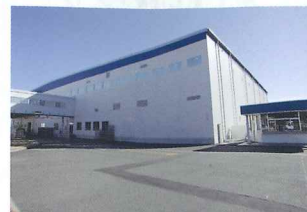
静岡金谷工場 粉体工場
